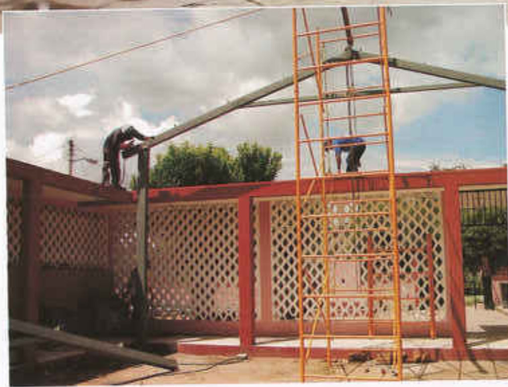
Construcción de Techumbre Esc. Benito Juárez, El Quiote
