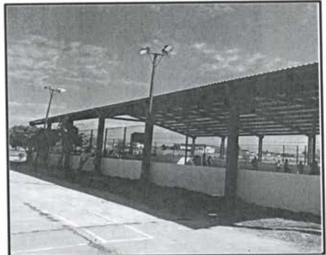
Foto 3 .Techumbre en Esc. Sec. Fed 3 Genaro Estrada, col. Francisco Villa
