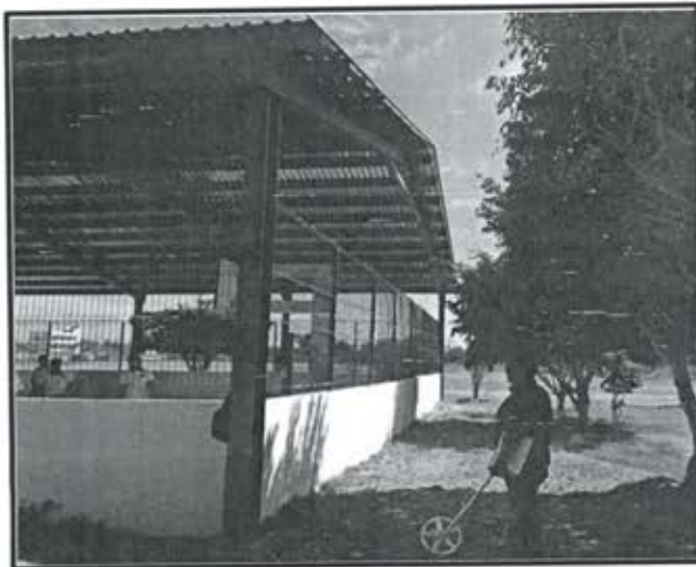
Foto 4.Techumbre en Esc. Sec. Fed 3 Genaro Estrada, col. Francisco Villa
