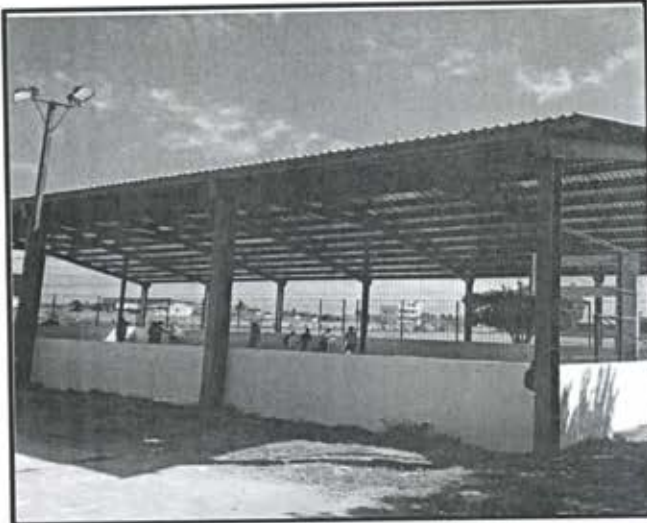
Foto 2. Techumbre en Esc. Sec. Fed 3 Genaro Estrada, col. Francisco Villa
