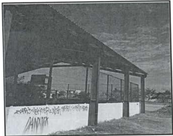
Foto 7. Techumbre en Esc. Sec. Fed 3 Genaro Estrada, col. Francisco Villa
