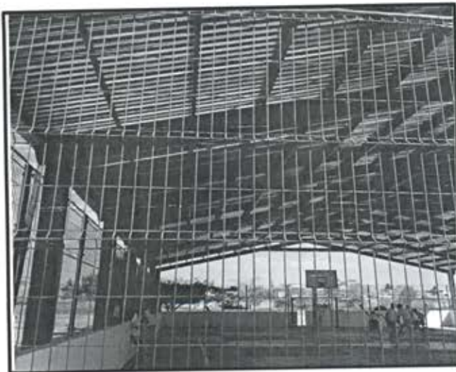
Foto 16. Techumbre en Esc. Sec. Fed 3 Genaro Estrada, col. Francisco Villa
