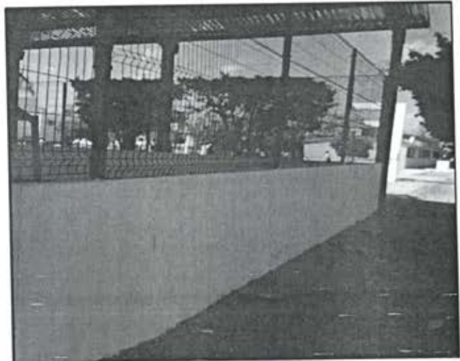
Foto 11. Techumbre en Esc. Sec. Fed 3 Genaro Estrada, col. Francisco Villa
