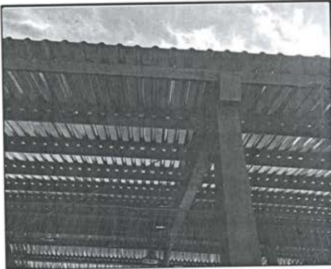
Foto 18. Techumbre en Esc. Sec. Fed 3 Genaro Estrada, col. Francisco Villa
