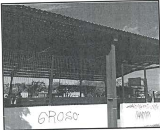
Foto 6. Techumbre en Esc. Sec. Fed 3 Genaro Estrada, col. Francisco Villa
