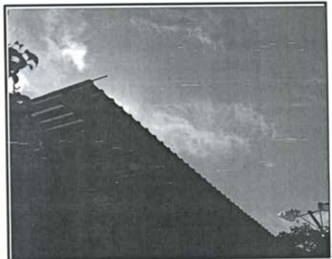
Foto 21. Techumbre en Esc. Sec. Fed 3 Genaro Estrada, col. Francisco Villa
