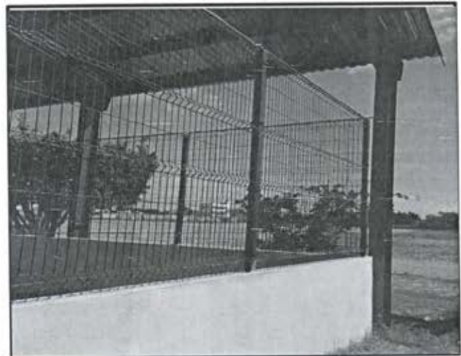
Foto 5. Techumbre en Esc. Sec. Fed 3 Genaro Estrada, col. Francisco Villa
