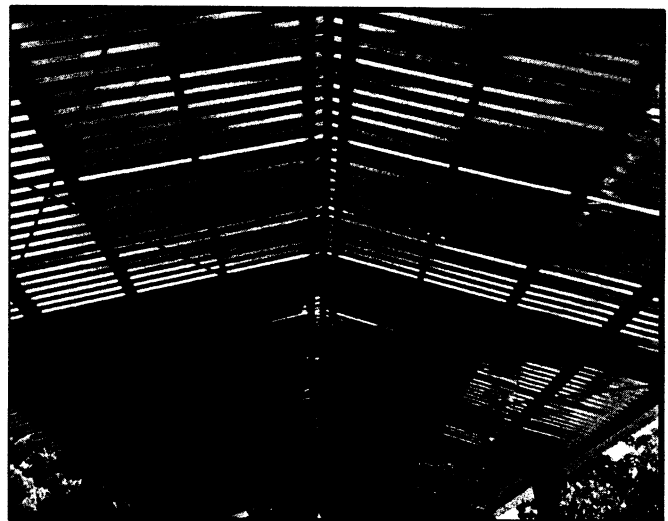
Foto 5. Techumbre en Esc. Prim. Felipe Carrillo Puerto , col. Lico Velarde
