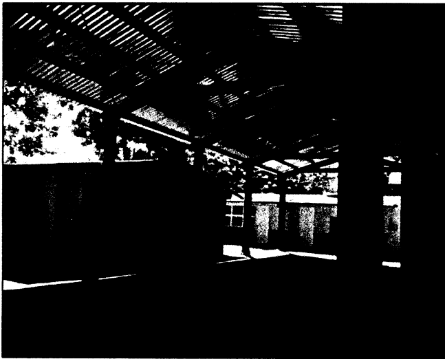
Foto 12. Techumbre en Esc. Prim. Felipe Carrillo Puerto , col. Lico Velarde
