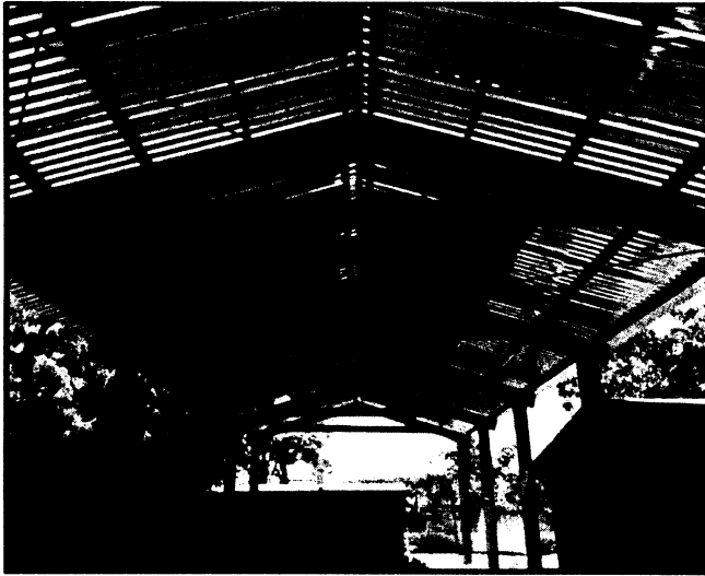
Foto 6. Techumbre en Esc. Prim. Felipe Carrillo Puerto , col. Lico Velarde
