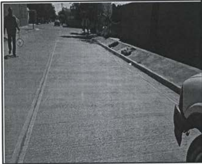
Foto 14. Pavimento Calle Alvaro Obregon Tramo Toledo Corro y Vicente Lombardo Toledano.
