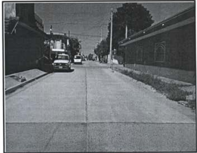
Foto 15. Pavimento Calle Alvaro Obregon Tramo Toledo Corro y Vicente Lombardo Toledano.
