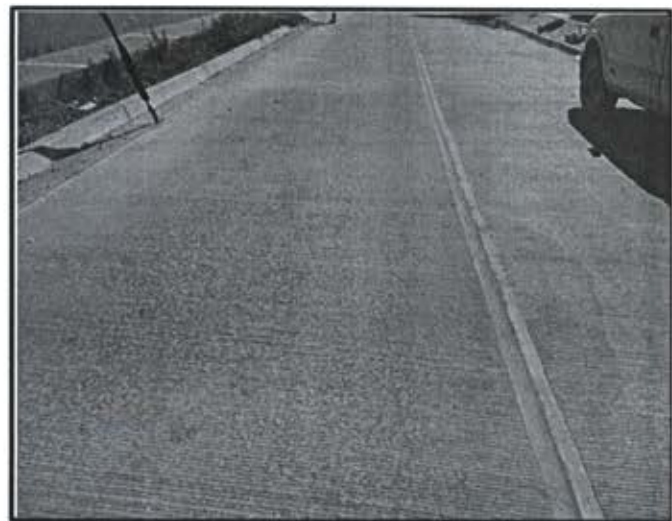
Foto 13. Pavimento Calle Alvaro Obregon Tramo Vicente Lombardo Toledano y Toledo Corro.
