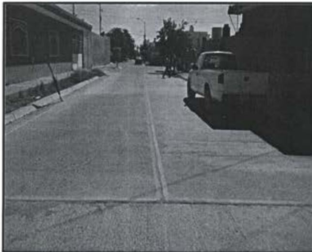
Foto 12. Pavimento Calle Alvaro Obregon cruce Vicente Lombardo Toledano.
