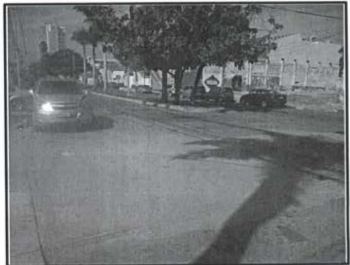
Foto 5. Reposicion de pavimento en av. Lola Beltran
