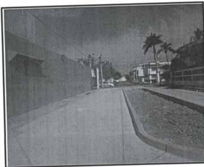
Foto 16. Pavimento de calle Rio Presidio
