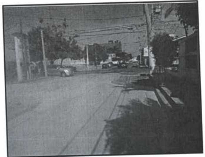
Foto 15. Pavimento de calle Rio Presidio
