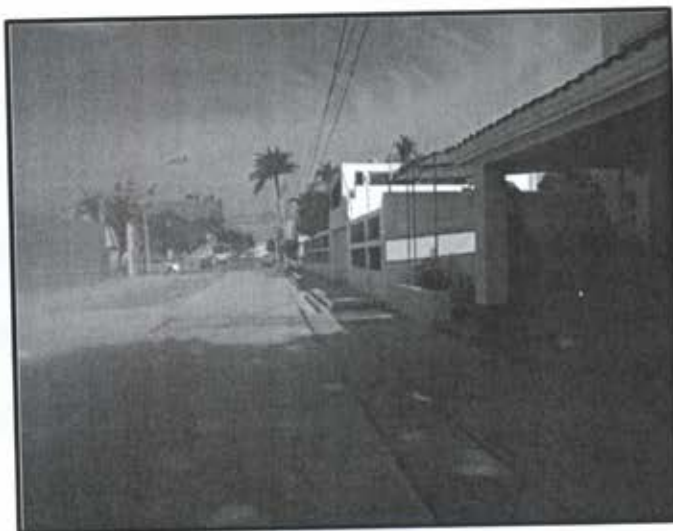
Foto 13. Pavimento de calle Rio Presidio
