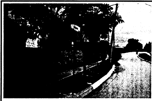
8.- PAVIMENTACION CALLE MANGOS, FRACC. LA FORESTA.
