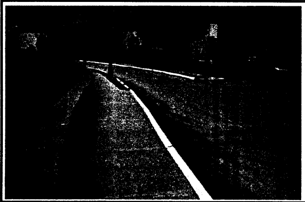
2.- PAVIMENTACION CALLE MANGOS, FRACC. LA FORESTA.
