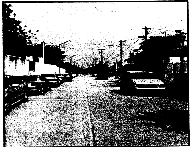
Foto 9. Pavimentación de calle Atardecer entre calle Relámpago y calle Nube, col. Villas del Sol.
