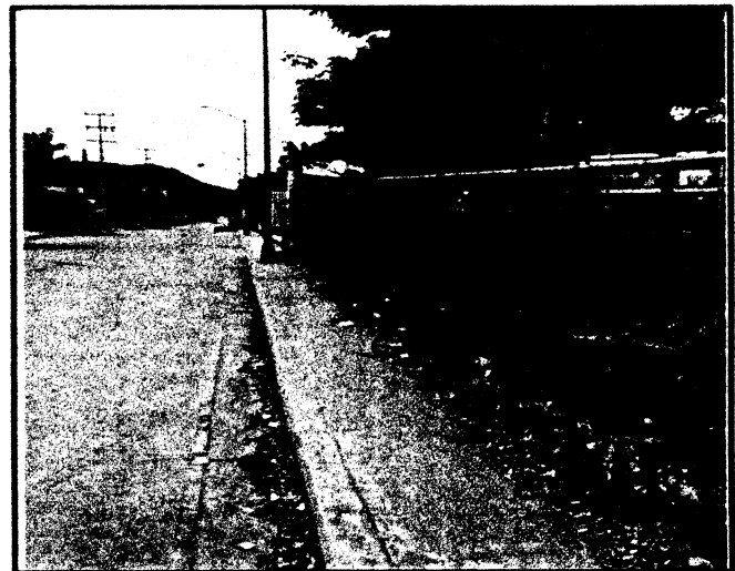
Foto 5. Pavimentación de calle Atardecer entre calle Relámpago y calle Nube, col. Villas del Sol.
