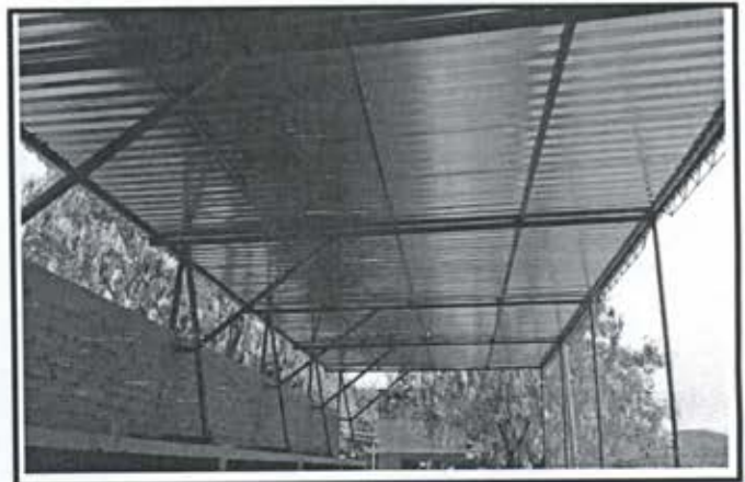
5.- Techumbre metalica Estadio de Beisbol Comunidad Siqueros.
