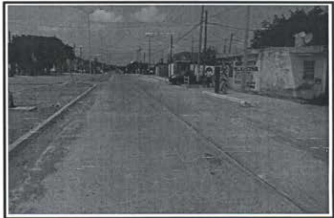
5.- Pavimentacion Avenida del Sol.
