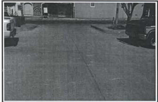
5.- Pavimentacion Calle Privada Huayacan Fraccionamiento Arboledas II.
