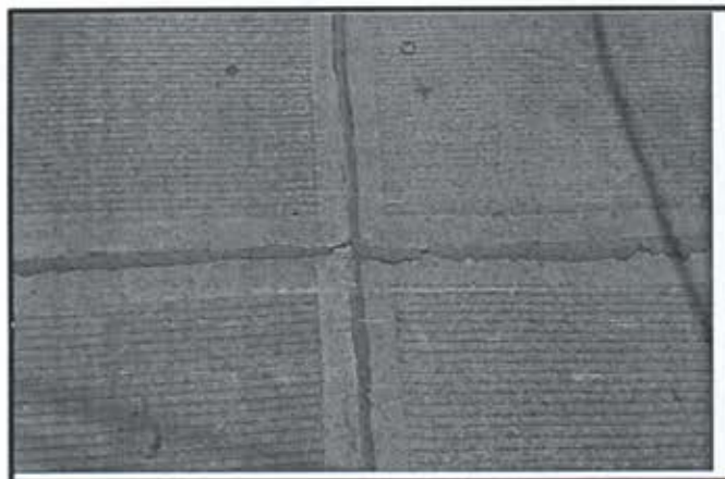
12.- Pavimentacion Calle Lazaro Cardenas.
