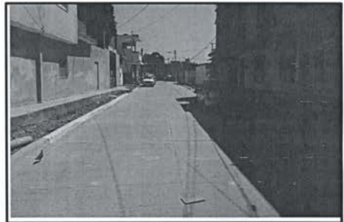
17.- Pavimentacion Calle Lazaro Cardenas.
