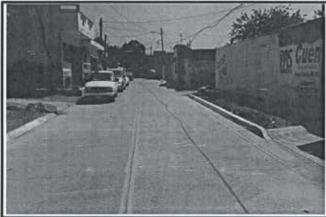
8.- Pavimentacion Calle Lazaro Cardenas.
