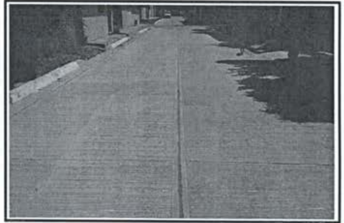
7.- Pavimentacion Calle Lazaro Cardenas.
