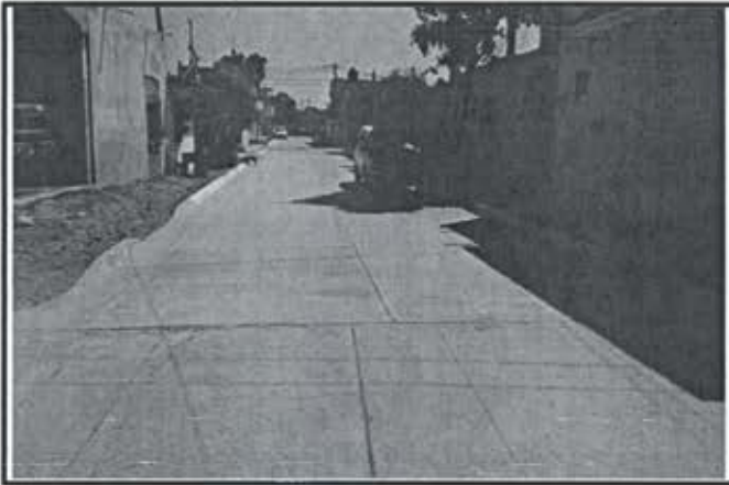
2.- Pavimentacion Calle Lazaro Cardenas.
