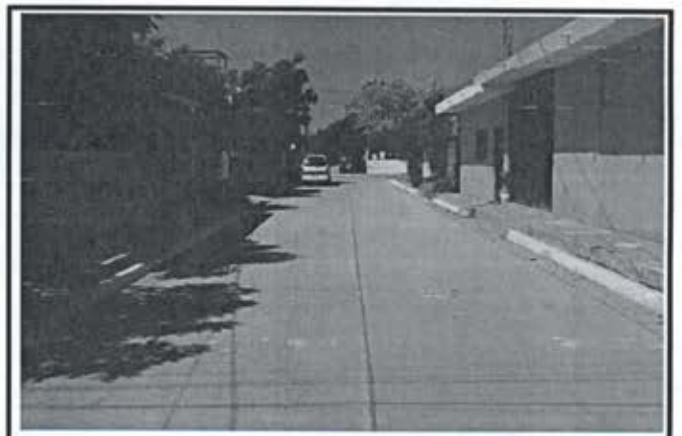
9.- Pavimentacion Calle Lazaro Cardenas.
