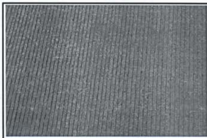
13.- Pavimentacion Calle Lazaro Cardenas.
