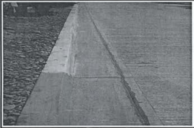
6.- Pavimentacion Calle Lazaro Cardenas.
