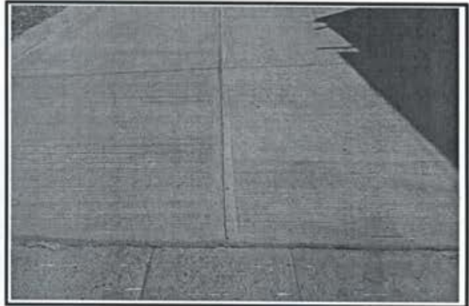
3.- Pavimentacion Calle Lazaro Cardenas.
