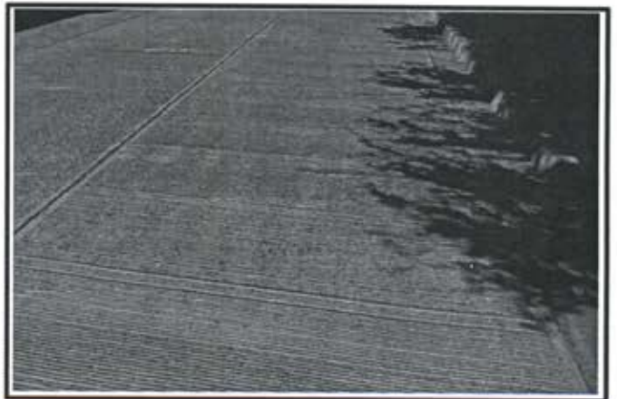
13.- Pavimentacion de calle Campeche Colonia Sanchez Celis.
