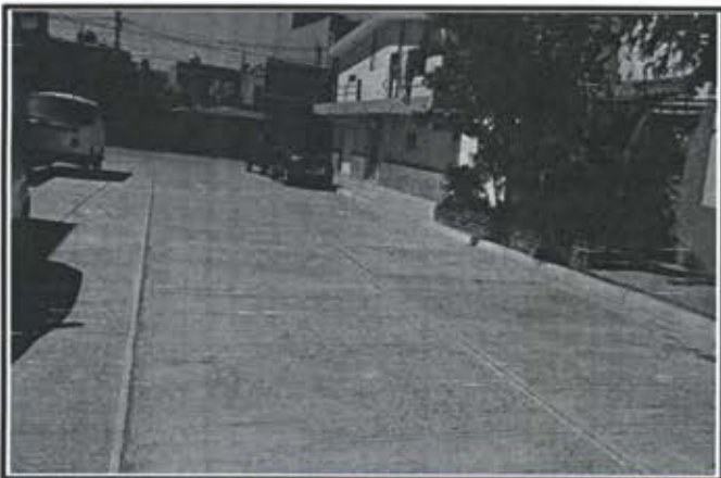
12.- Pavimentacion de calle Campeche Colonia Sanchez Celis.
