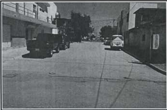
6.- Pavimentacion de calle Campeche Colonia Sanchez Celis.
