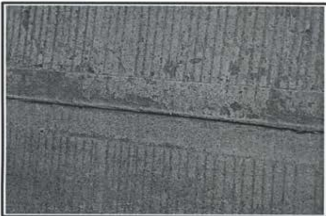
10.- Pavimentacion de calle Campeche Colonia Sanchez Celis.
