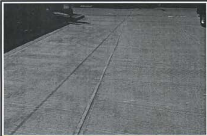
8.- Pavimentacion de calle Campeche Colonia Sanchez Celis.
