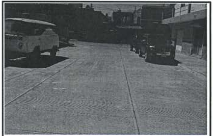
9.- Pavimentacion de calle Campeche Colonia Sanchez Celis.
