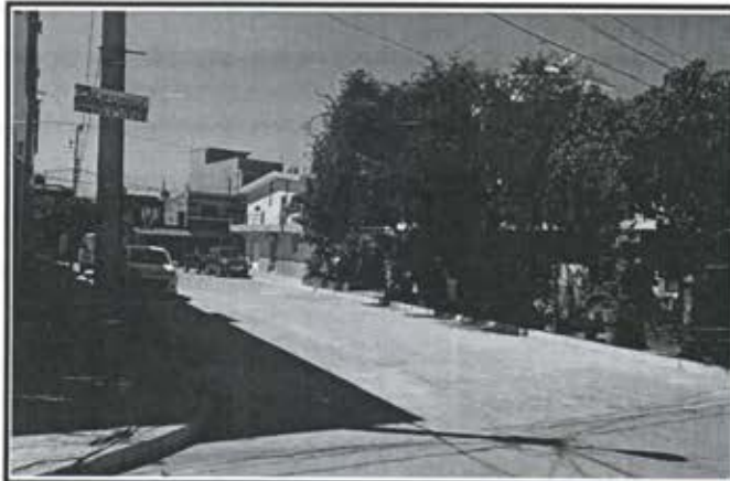
4.- Pavimentacion de calle Campeche Colonia Sanchez Celis.
