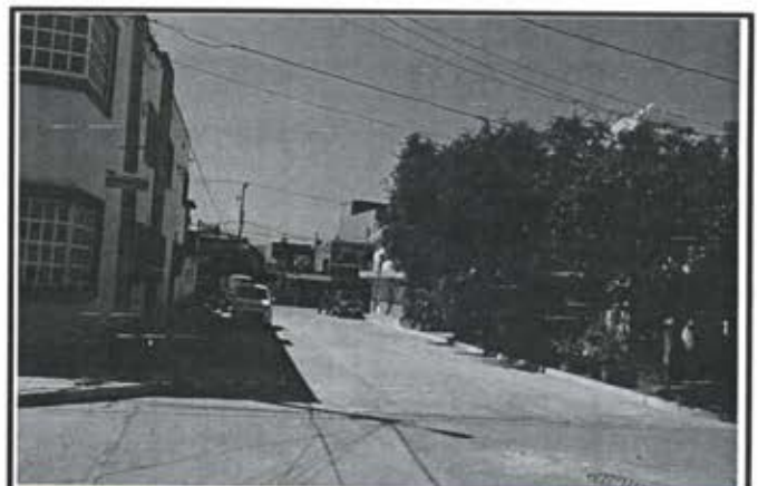
5.- Pavimentacion de calle Campeche Colonia Sanchez Celis.
