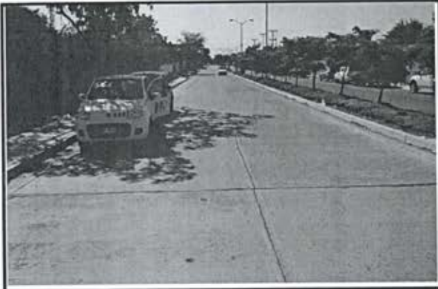
2.- Pavimento de concreto premezclado f'c = 250 kg/cm 2 . Av. Jabalies
