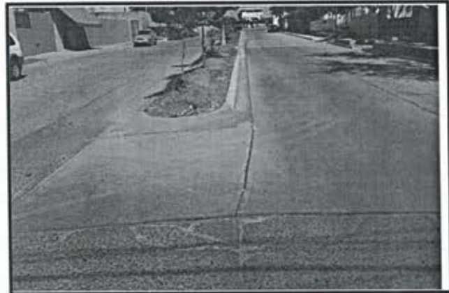
11.- Pavimento de concreto premezclado f'c= 250 kg/cm2. Av. Jabalies esquina con calle, Antonio Plaza Ataide.
