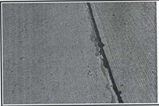
6.- Junta constructiva en pavimento.
