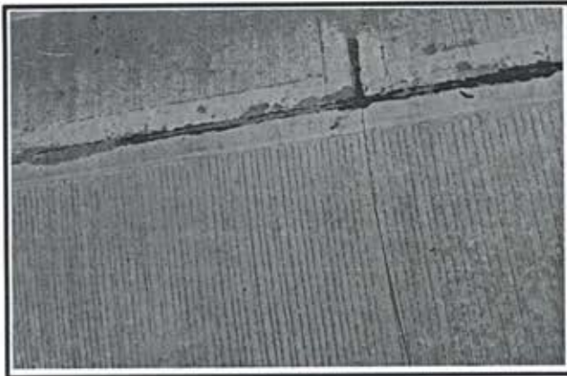
8.- Calafateo de Losa y guarniciones.
