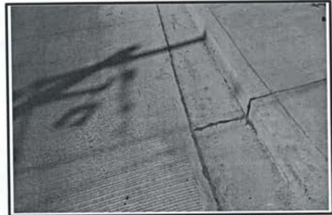
17.- Pavimento de concreto premezclado f'c = 250 kg/cm 2 . Av. Jabalies (Calafateo)
