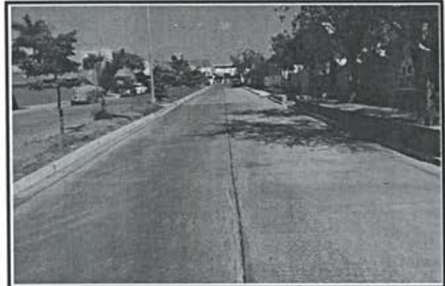
3.- Pavimento de concreto premezclado f'c = 250 kg/cm 2 . Av. Jabalies.
