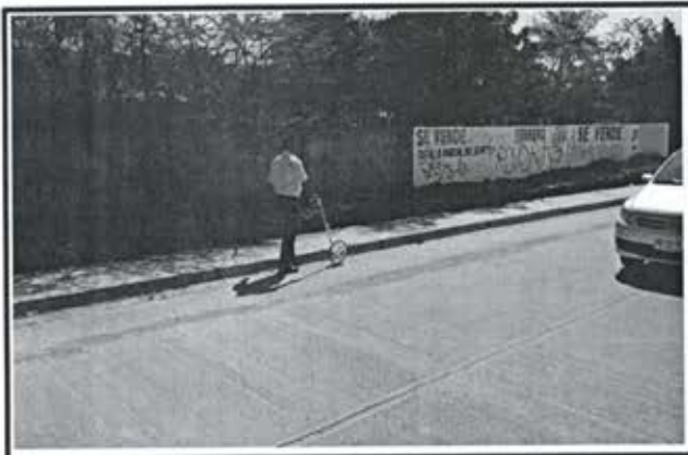
4.- Pavimento de concreto premezclado f'c = 250 kg/cm 2 . Av. Jabalies (Medicion)
