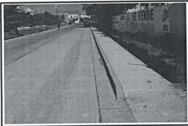
12.- Banqueta de concreto premezclado f'c= 200 kg/cm2. Av. Jabalies
