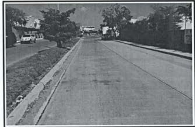
13.- Pavimento de concreto premezclado f'c= 250 kg/cm2. Av. Jabalies
