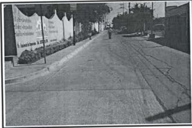
14.- Pavimento de concreto premezclado f'c = 250 kg/cm 2 . Av. Jabalies
