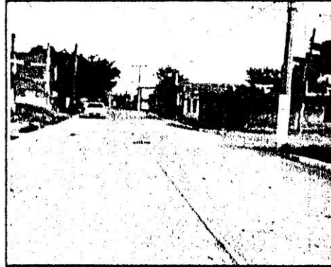
Foto 9. Pavimentación de calle Emiliano Zapata entre calle Naranja y canal, col. Jesus García
