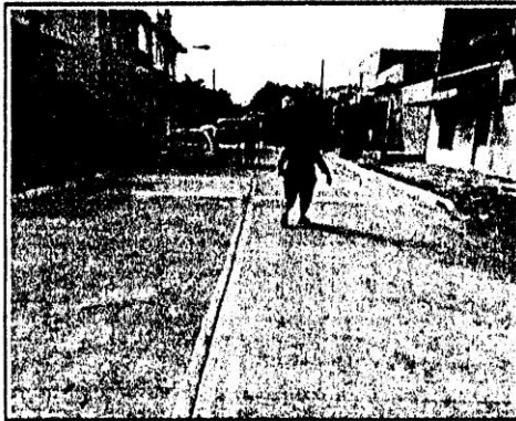
Foto 10. Pavimentación de calle Emiliano Zapata entre calle Naranja y canal, col. Jesus Garcia
