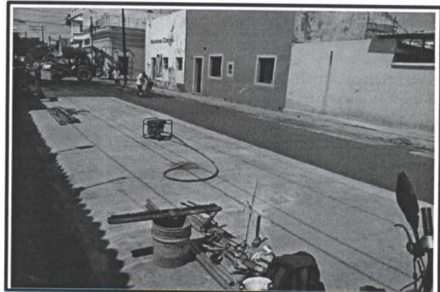
5.- Reposicion de pavimento de concreto Premezclado Especial a 24 Horas Hidraulico de 20 cm de espesor.
