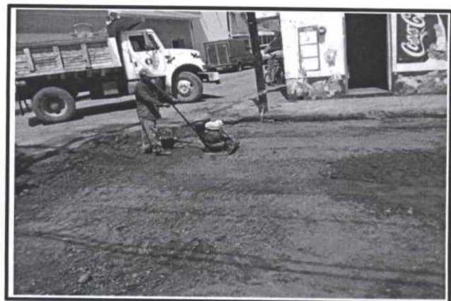
9.- Colocacion y compactacione base para pavimento de 20 cm.
