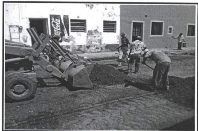
13.- Colocacion de Base para pavimento de 20 cm.
