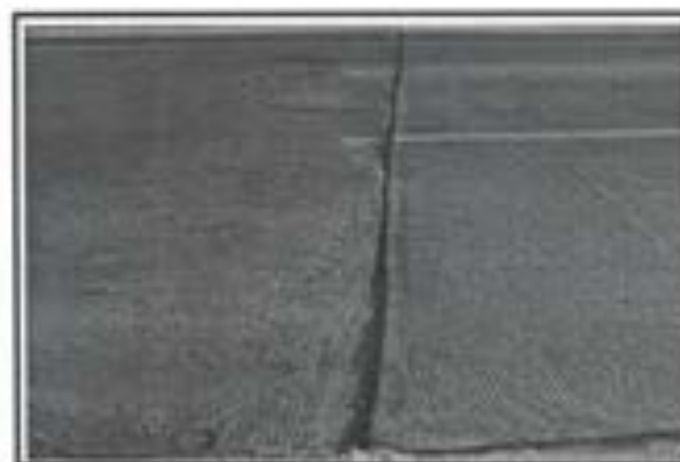
13.- Losa de Concreto FC 250 KG/CM2.
