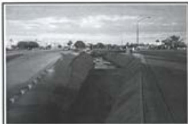
17.- Losa de Concreto en Canal.
