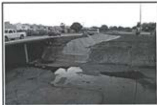
5.- Losa de Concreto en Canal, Conexión al viejo canal.
