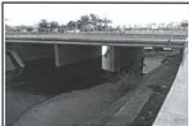
9.- Muros de Concreto armados colocados en losa puente.
