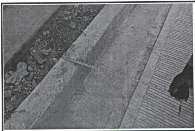
12.- Guarnicion tipo "L" de 15x30x60 de concreto premezclado F'C= 250 KG/CM2 calle Tomas Urbina.
