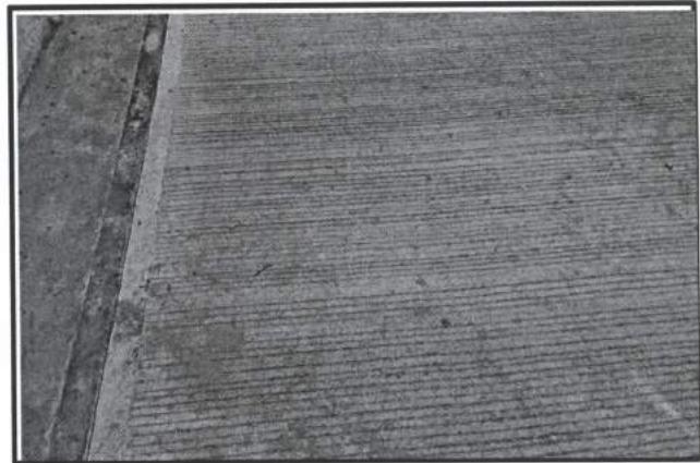
7.- Acabado escobillado en pavimento calle Tomas Urbina.
