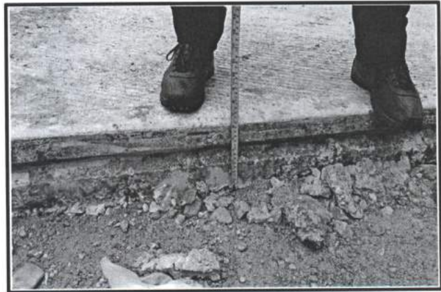
13.- Losa de pavimento de 15 cm de espesor calle Tomas Urbina.
