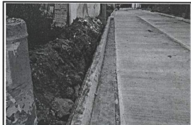
5.- Pavimento de concreto premezclado F'C= 250 kg/cm2 de 15 cm de espesor, Calle Tomas Urbina.
