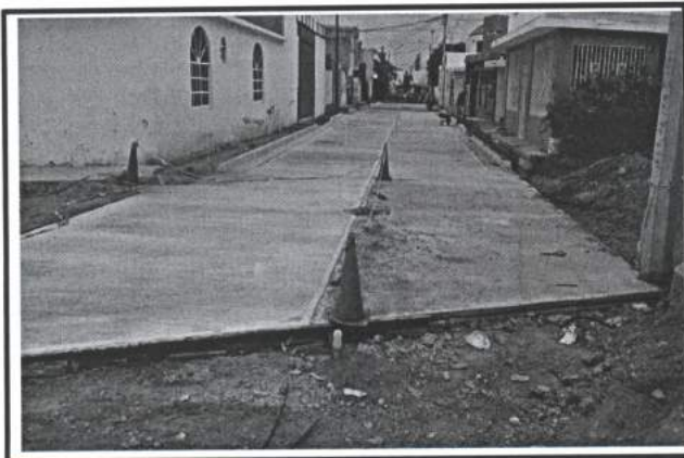
8.- Terminacion de tramo pavimentado en calle Tomas Urbina esquina con calle Plan de Ayala, Colonia Francisco Villa.
