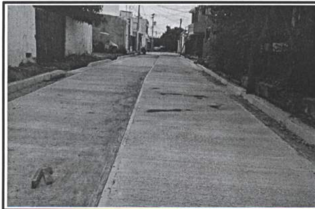
4.- Pavimento de concreto premezclado F'C= 250 kg/cm2 de 15 cm de espesor, Calle Tomas Urbina.
