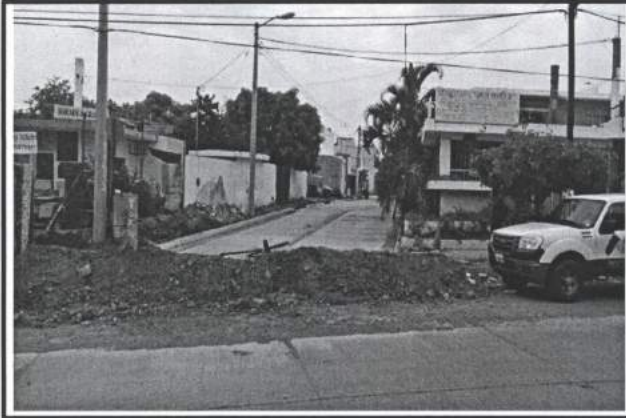
2.- Inicia tramo de pavimentacion calle Tomas Urbina, esquina con Av. Bicentenario.
