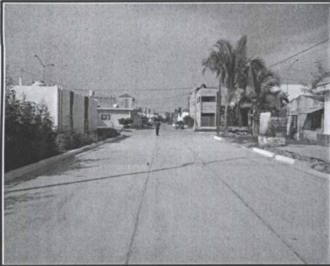
Foto 14. Pavimentación calle Mariano Abasolo tramo Revolución y Fco. I. Madero
