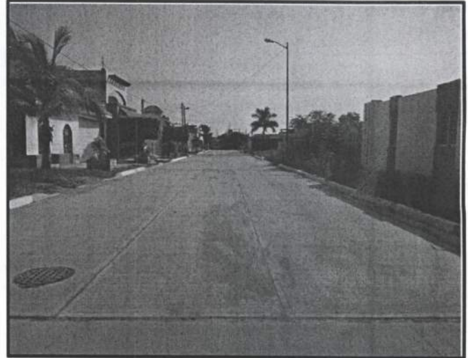
Foto 15. Pavimentación calle Mariano Abasolo unión con pavimento calle Fco. I. Madero
