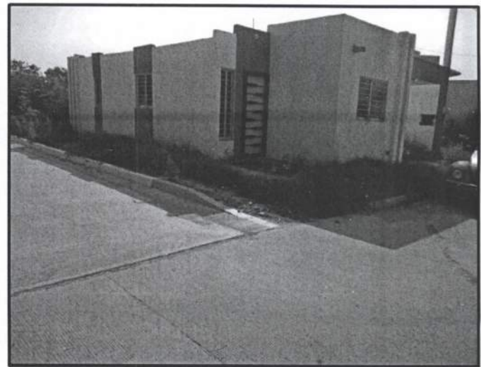
Foto 17. Pavimentación C. Mariano Abasolo esquina con calle Fco. I. Madero
