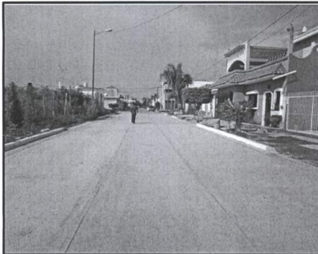
Foto 12. Pavimentación calle Mariano Abasolo tramo Revolución y Fco. I. Madero
