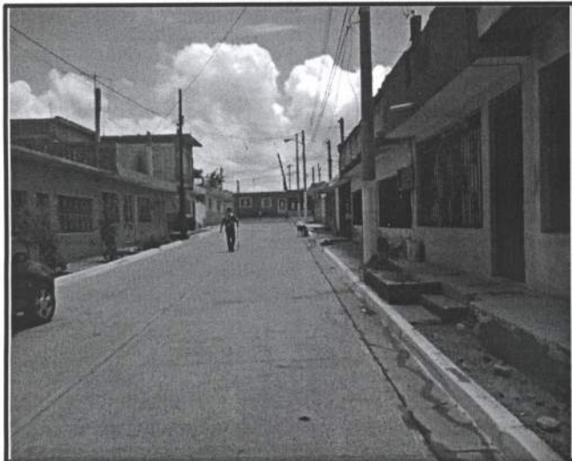
Foto 8. PAVIMENTO C. CONSTITUCION DE 1917, ENTRE C. MARGARITA MAZA DE JUAREZ Y FERROCARRIL
