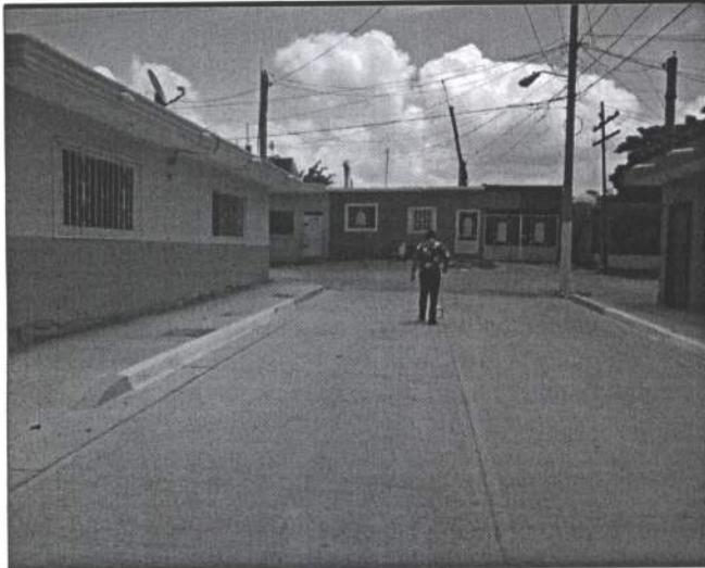
Foto 10. PAVIMENTO C. CONSTITUCION DE 1917 ENTRE C. MARGARITA MAZA DE JUAREZ Y FERROCARRIL
