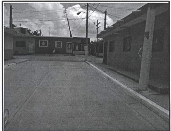
Foto 9. PAVIMENTO C. CONSTITUCION DE 1917 ENTRE C. MARGARITA MAZA DE JUAREZ Y FERROCARRIL
