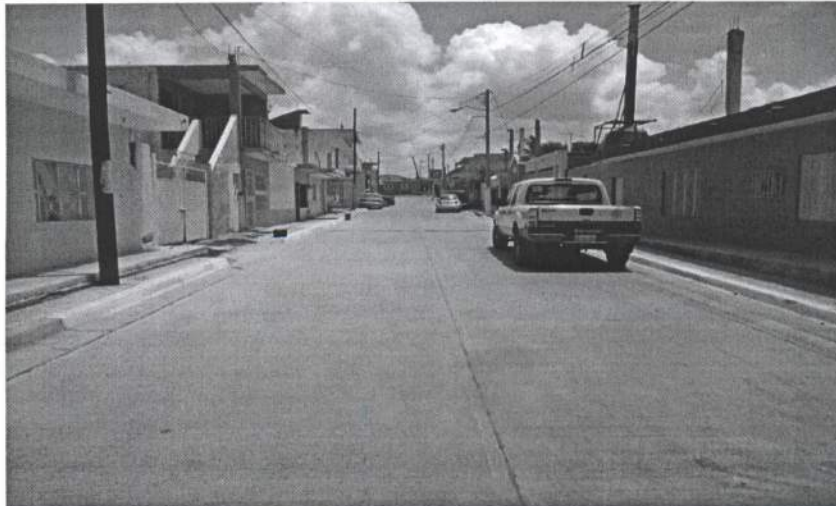
Foto 1 . PAVIMENTO C. CONSTITUCION DE 1917 ENTRE CALLE MARGARITA MAZA DE JUAREZ Y FERROCARRIL, COL. JESUS GARCIA
