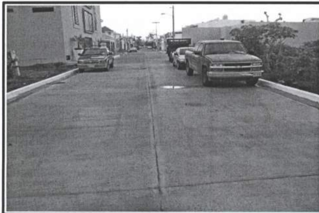
12.- Pavimento en Calle Playa Copa Cabana
