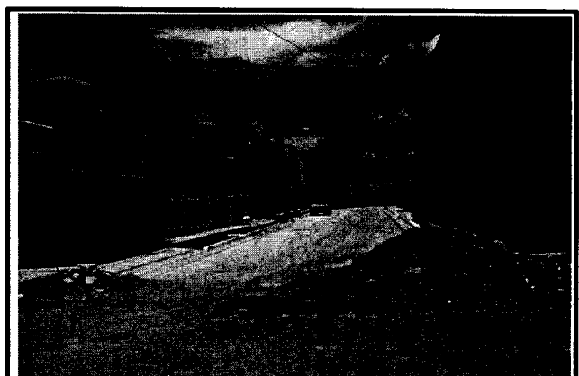
9.- Fin de pavimento en calle zaragoza.
