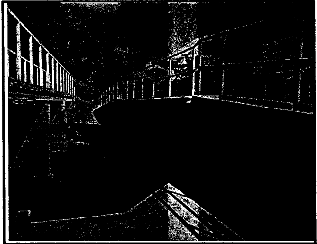
Foto 11. Construcción de puente vehicular y lavaderos
