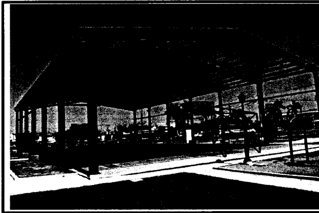
4.- Techumbre metalica en cancha de usos multiples.
