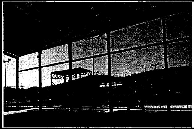
6.- Techumbre metalica en cancha de usos multiples.
