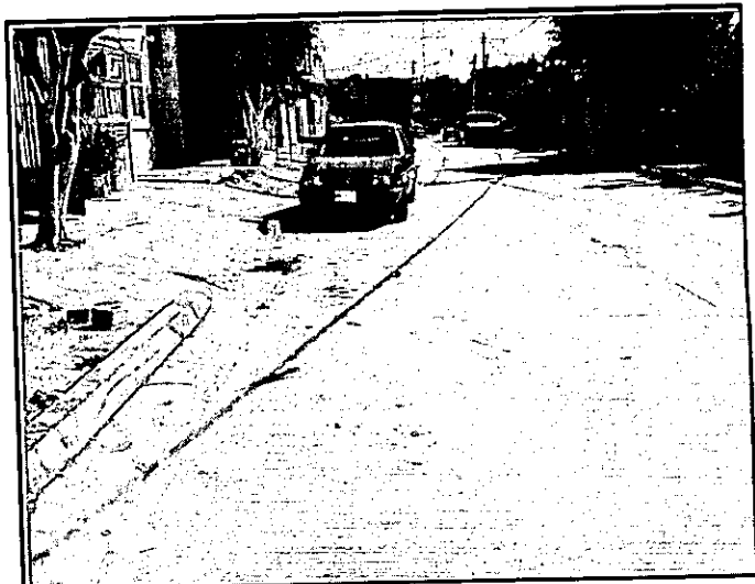
Foto 3 Pavimento calle Humberto Mariles entre Juan de la Barrera y Joaquín Capilla, col. Benito Juarez
