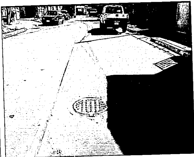
Foto 2. Pavimento calle Humberto Mariles entre Juan de la Barrera y Joaquin Capilla, col. Benito Juarez
