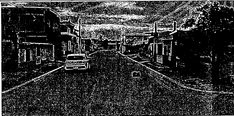
Foto 1. Pavimentación de la calle Francisco I. Madero entre Heroes Revolucionarios y Derecho de via.
