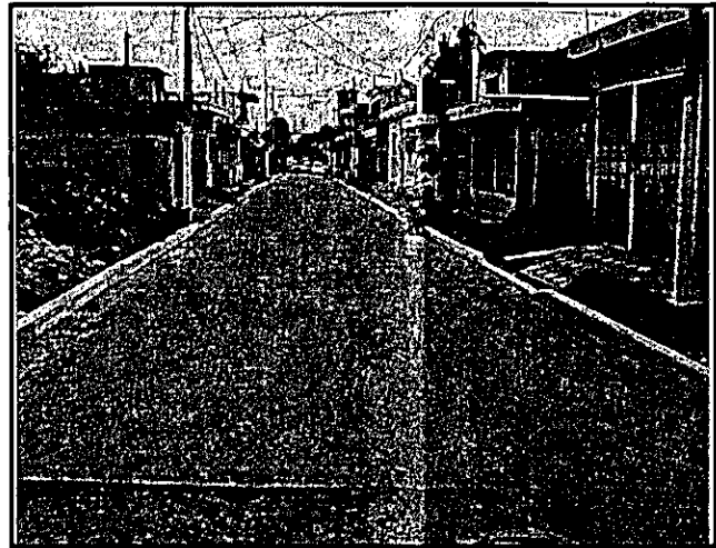
Foto 9. Pavimentación de la calle Francisco I. Madero entre Heroes Revolucionarios y Derecho de via
