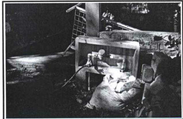
9.- Tomas domiciliarias en la colonia Lomas de Monterrey.
