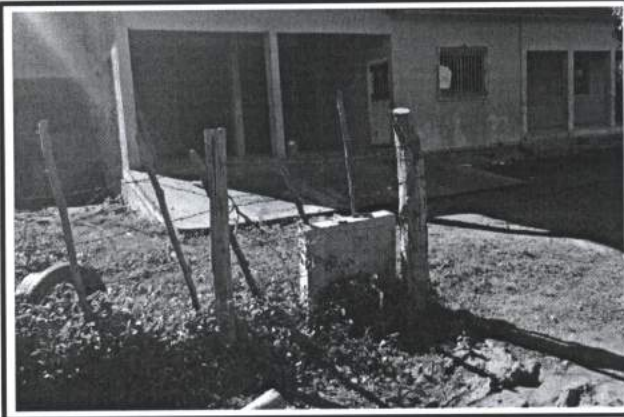
2.- Tomas domiciliarias en la colonia Lomas de Monterrey.
