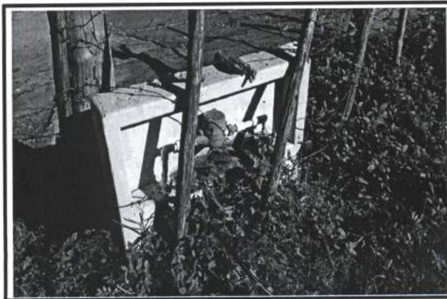
8.- Tomas domiciliarias en la colonia Lomas de Monterrey.
