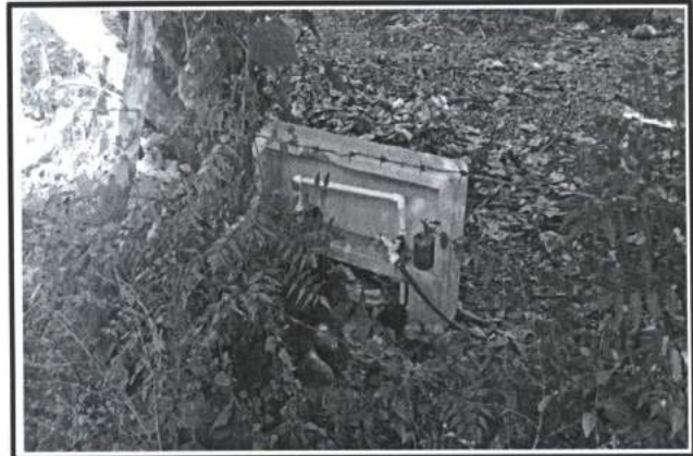
7.- Tomas domiciliarias en la colonia Lomas de Monterrey.
