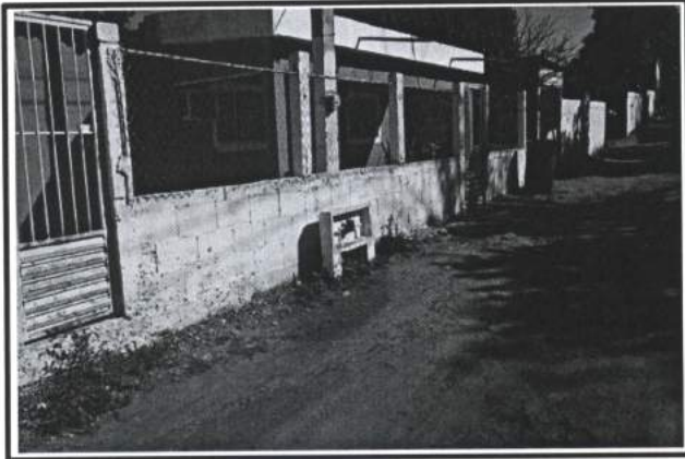
6.- Tomas domiciliarias en la colonia Lomas de Monterrey.
