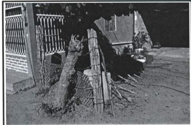
5.- Tomas domiciliarias en la colonia Lomas de Monterrey.
