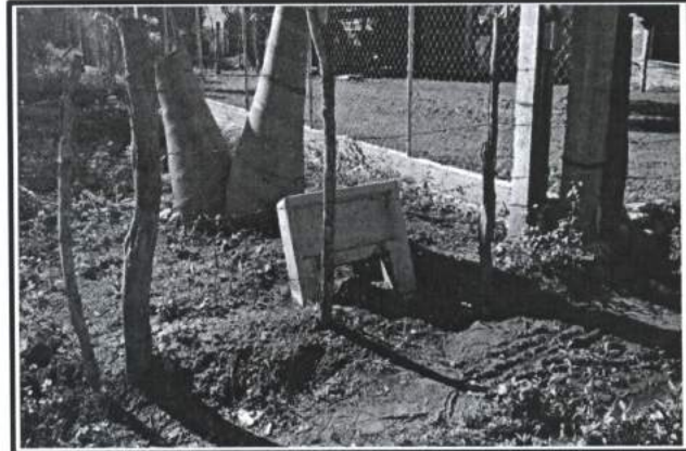
3.- Tomas domiciliarias en la colonia Lomas de Monterrey.
