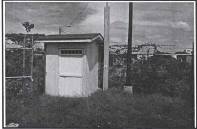
3.- Carcamo colonia nuevo milenio. (caseta de controles)
